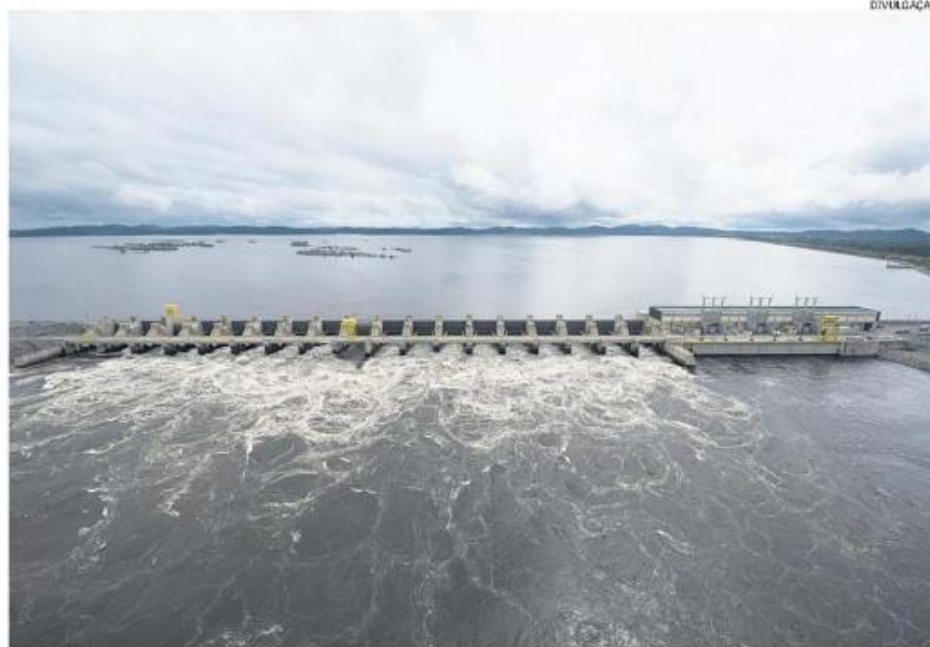
Vista parcial da hidrelétrica que está sendo contruída na bacia do Rio Xingu, na região de Altamira (PA)
